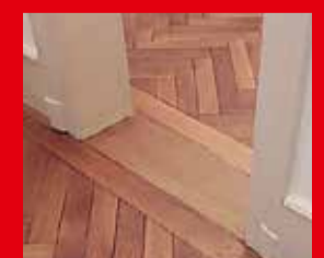
Abbau von Schwellen
